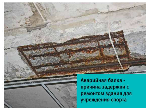
В бывшем здании КБО ныне делают капремонт
